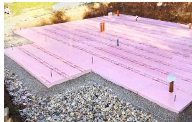
Perimeterdämmungen mit XPS-Dämmstoffen sind ein Beispiel für Anwendungen, die eine allgemeine Bauartgenehmigung benötigen.
