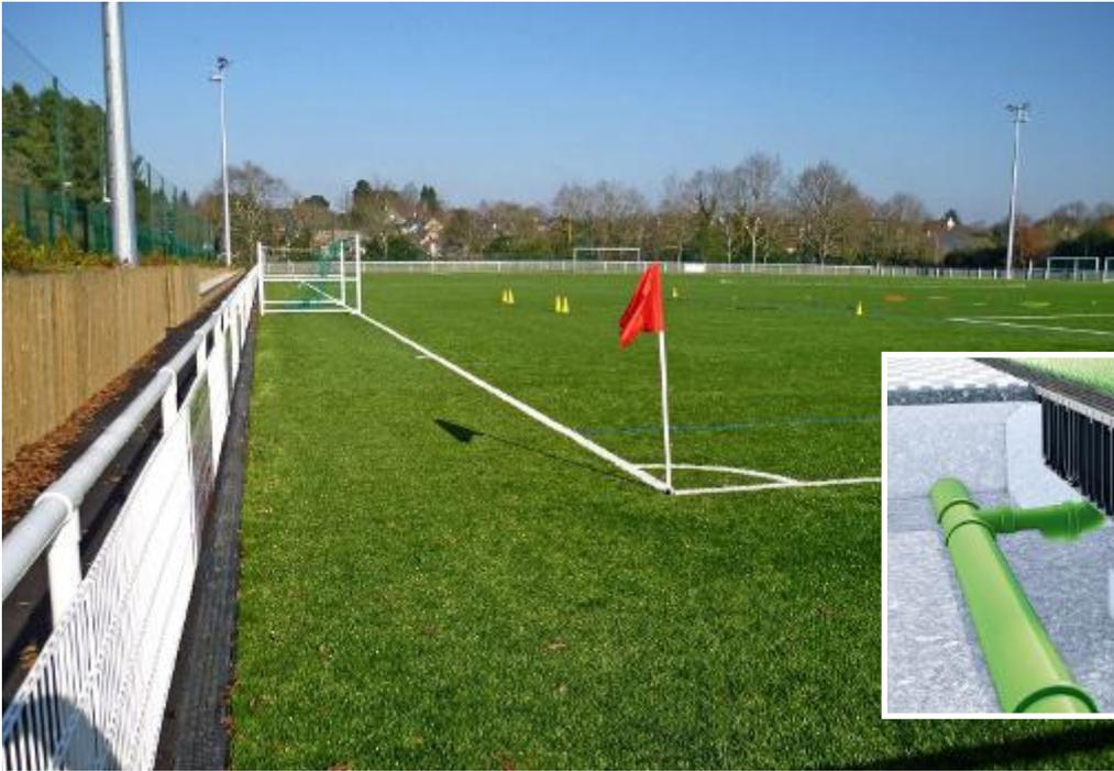
*Sportfix®Clean-Rinnen bieten zusätzlich zur sicheren Entwässerung auch die Filterung des Abwassers und das dauerhafte Zurückhalten von Kunststoffpartikeln und Schadstoffen.*
